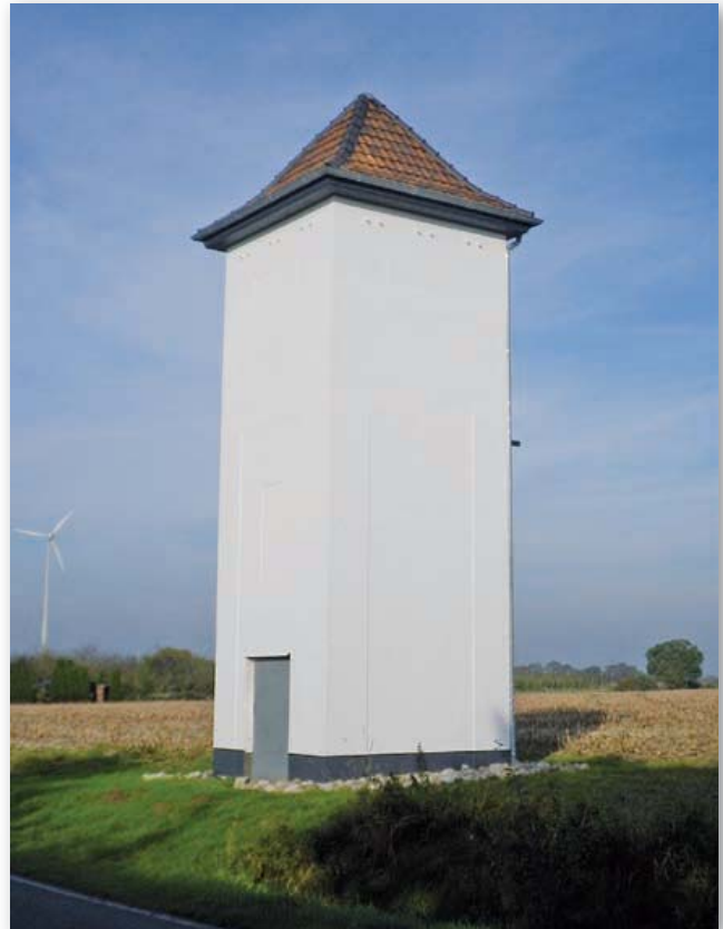
Abb. 3: Transformatorenturm in Schermbeck-Besten „Weißer Turm Besten“, Blick von der Kirchhellener Straße in Richtung Dorsten. Foto: C. Poßer 2014
