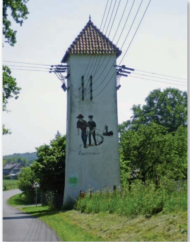
Abb. 6: Transformatorernturm in Hünxe-Krudenburg.
