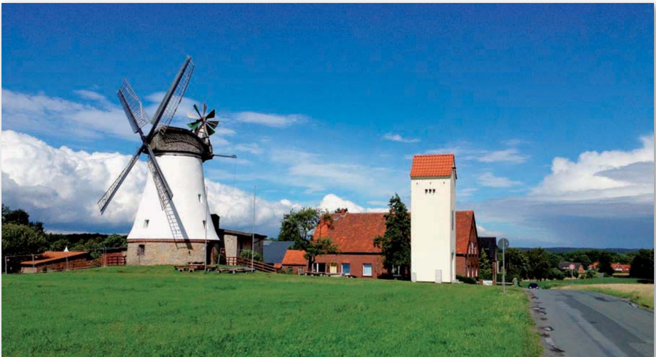
Abb. 2: Trafoturmstation Lechtinger Mühlenverein.
