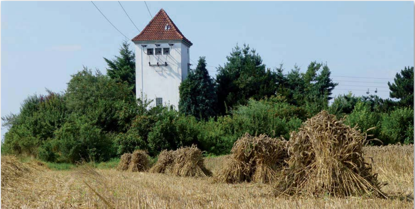
Abb. 1: Trafoturmstation Mühle Körner Wesel.
