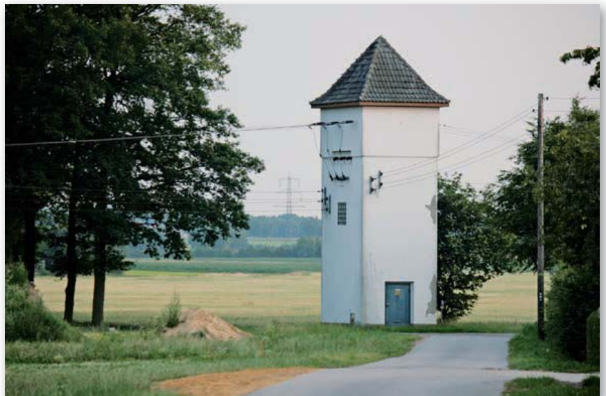
Abb. 1: Transformatorenturm in Hamminkeln-Havelich.
