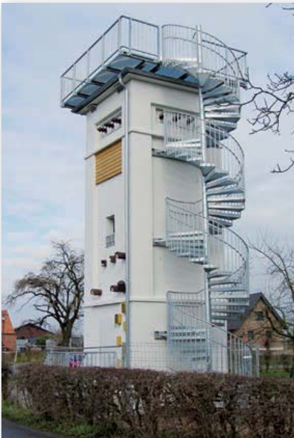
Abb. 6: Trafoturmstation Bislicher Insel.
