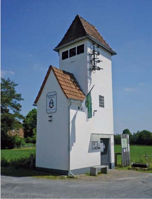
Abb. 5: Trafostation in Schermbeck-Damm.
